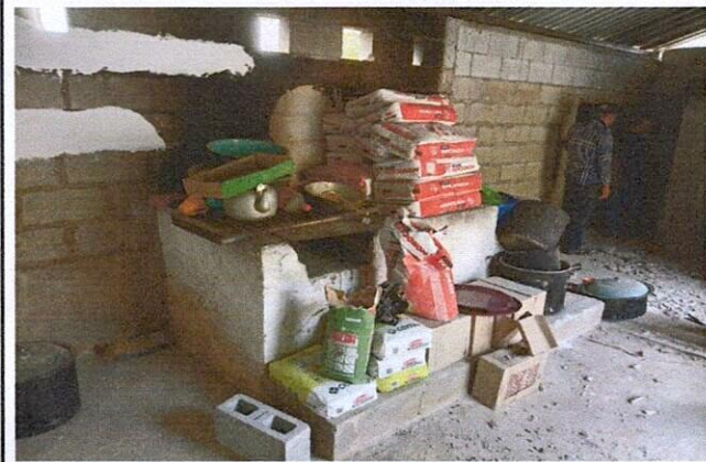
Foto 3: Reparación de área de cocina.
