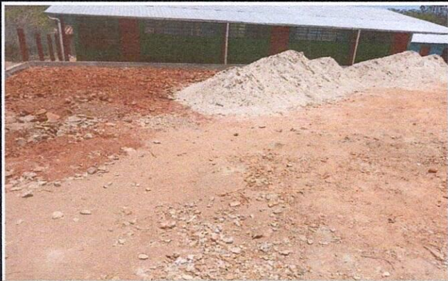
Foto 1: Mejoramiento de losa de patio.
