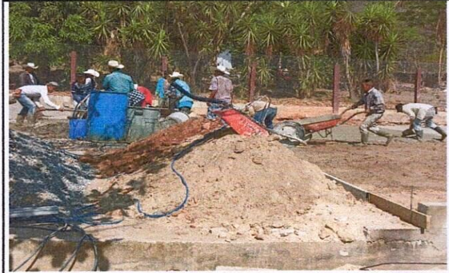
Foto 2: Mejoramiento de losa de patio.
